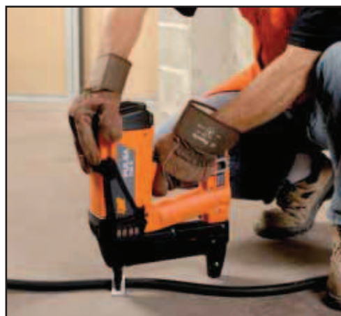
Nastřelování plastových úchytek Spit P-CLIP do podlahy
