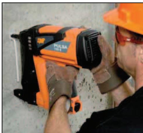
Nastřelování nákrůžků s příchytkou Spit CT-CLIP do stěny
