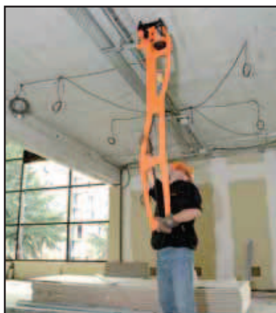
Nastřelování kabelových příchytek do stropu s použitím nástavce Spit Pulsa Lift (viz s. 44)
