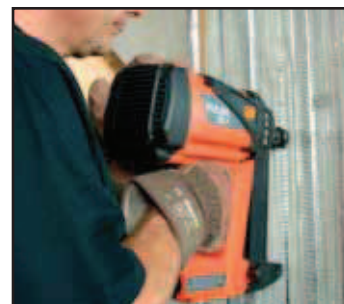
Nastřelování kovových rastrů (s podložkou Ø 25 mm)
