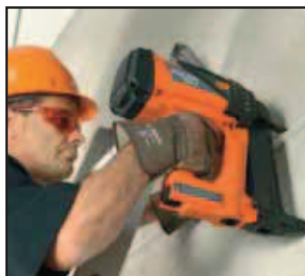
Nastřelování do závěsu podhledu
