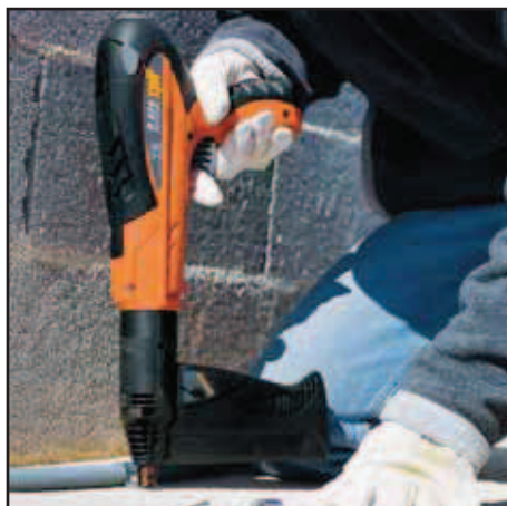
Upevnění kovových příchytek do podlahy
