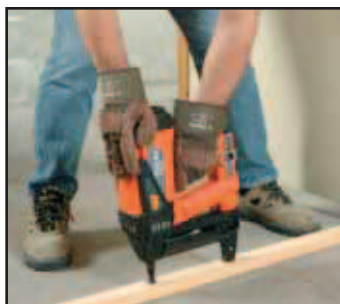
Nastřelování dřevěného profilu
