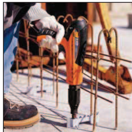
Upevnění rozpěry bednění
