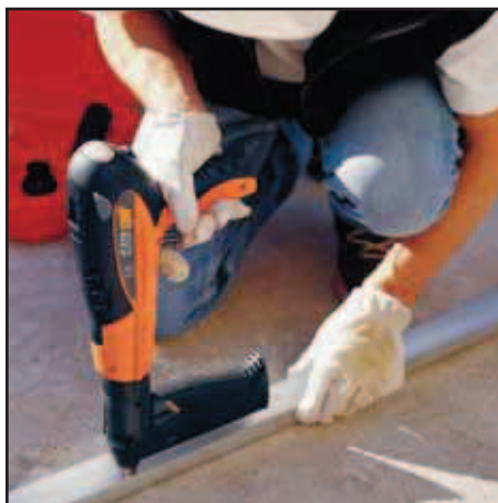
Upevnění profilu do podlahy
