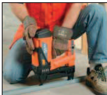
Nastřelování kovového profilu
