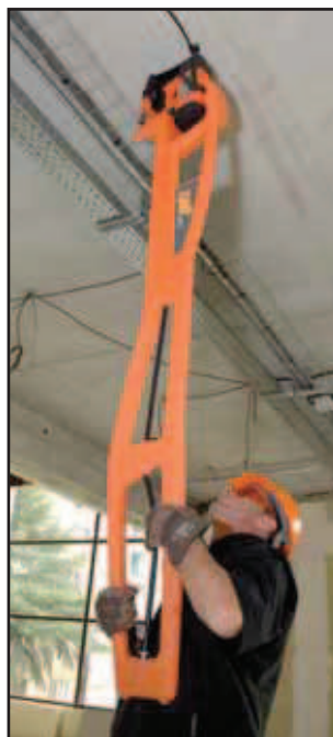
Nastřelování příchytek SPIT Clipelec
